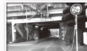
LED照明設置
