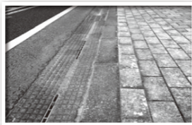
ブロック固定完了
