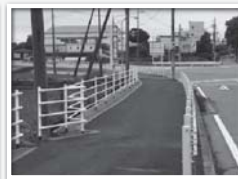
歩道整備完了
