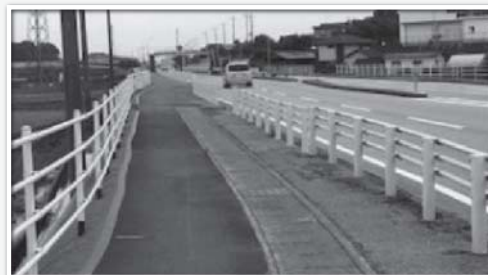
拡幅された歩道
