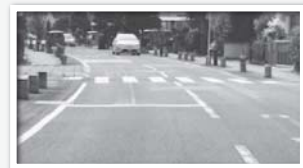
横断歩道の改修
