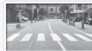
横断歩道の改修
