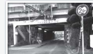
LED照明設置
