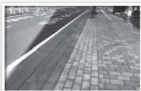
インターロック整備完了
