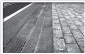
ブロック固定完了
