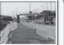
歩道整備完了
